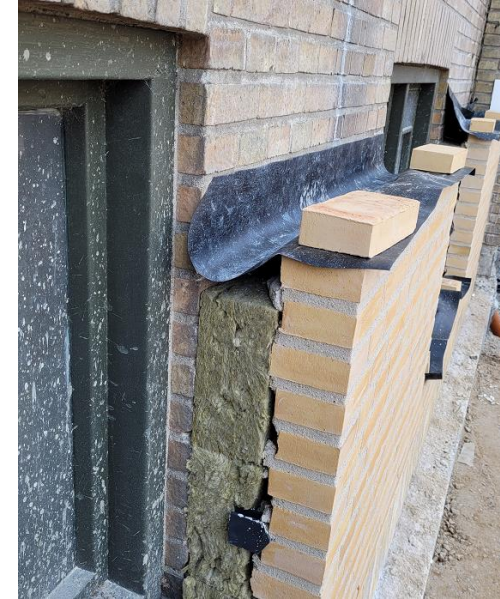
2 eksempler på efterisolering af facade
