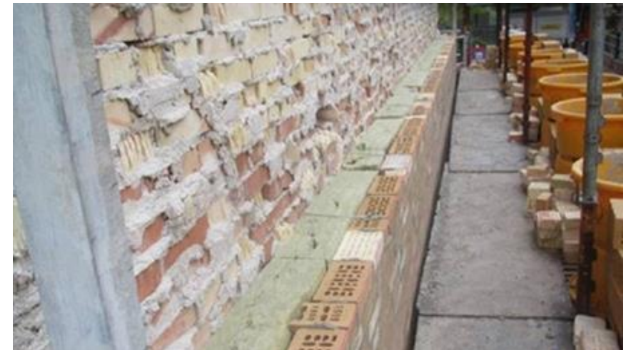
2 eksempler på efterisolering af facade
