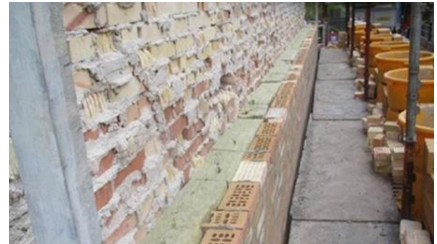
2 eksempler på efterisolering af facade
