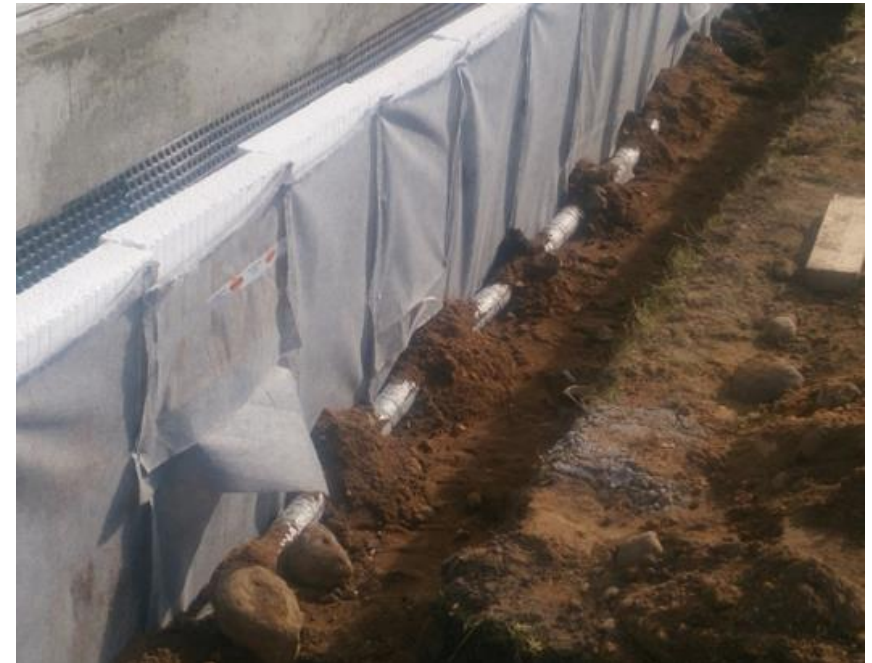
Eksempel på efterisolering af kælder
