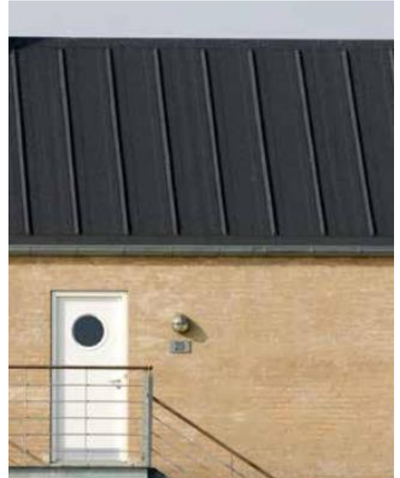
Eksempel på tagpaptag med trekantlister
