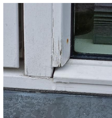
Udskiftning af vinduer
