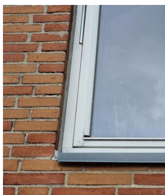
Udskiftning af vinduer
