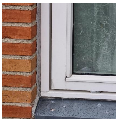
Udskiftning af vinduer
