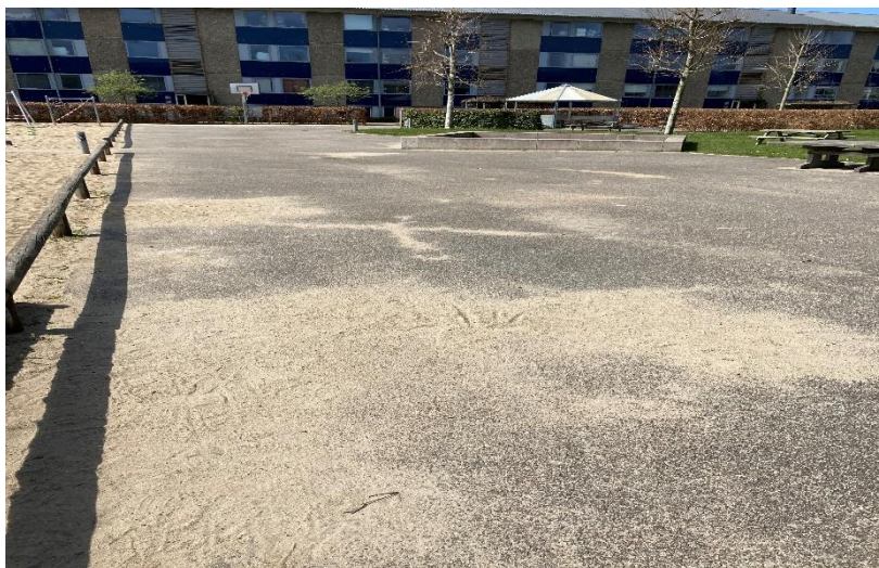
Udskiftning af asfalt
