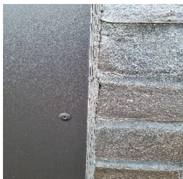
Udskiftning af elastisk fuge imellem skur og bolig.
