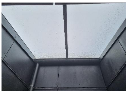
Rengøring af ovenlysvinduer.
