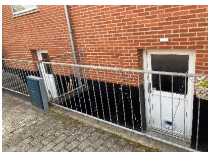
Udskiftning af kælderdoor og skurdør.
