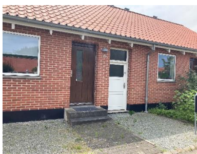
Udskiftning af gl. hoveddør.
