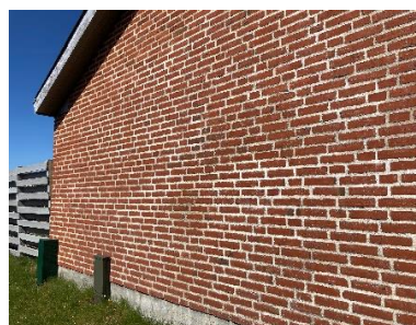
Omfugning af murværk.
