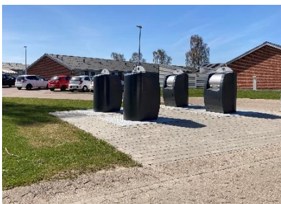
Yderligere belægning ved affaldsøer.
