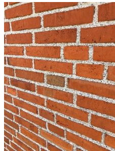
Omfugning af murværk.
