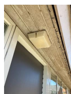
Udskiftning af 105 stk. udendørslamper i udhæng.
