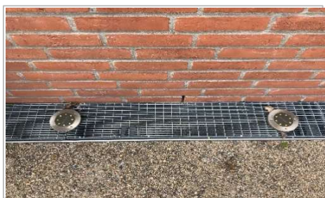
Sokkelaffugter bliver lavet på de resterende bygninger
