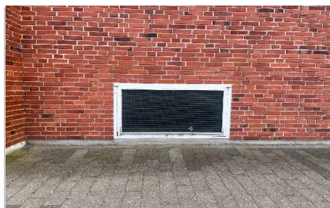
Udskiftning af vinduer og døre i kælder
