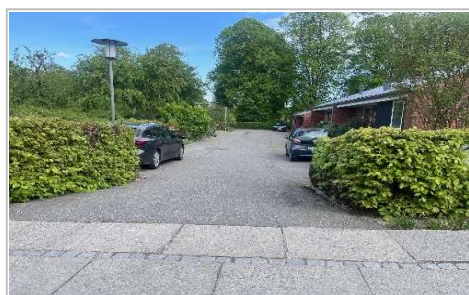
Udskifning af belægning
