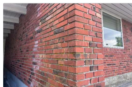
Omfugning af murværk
