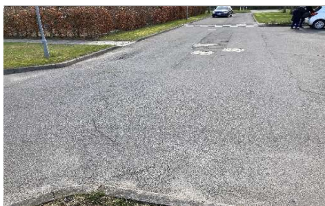
Udskiftning af asfalt.
