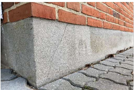
Reparation af sokkel
