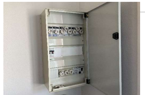
Udskiftning af sikringsgrupper til automat-sikringer og hpfi-relæ
