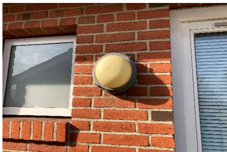
Udskiftning af udendøslamper
