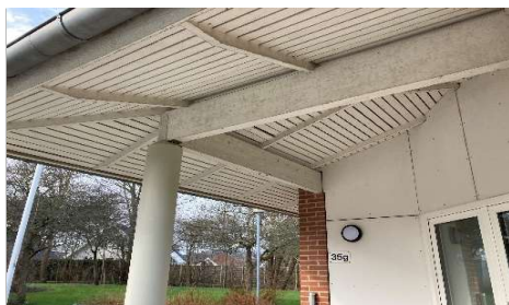
Rengøring af udhæng og indgangspartier
