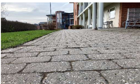
Opretning og delreparation af belægning
