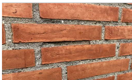
Reparation af mørtelfuger
