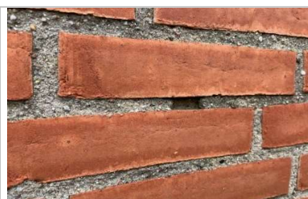
Reparation af mørtelfuger
