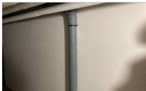
Udskiftning af vandrør.
