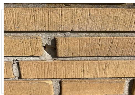
Omfugning af murværk
