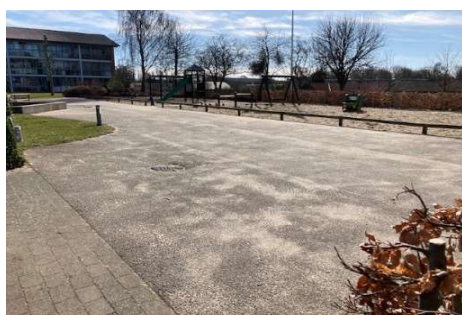
Udskiftning af asfalt
