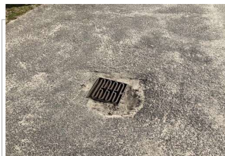
Udskiftning af asfalt
