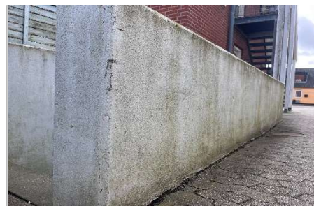
Algebehandling af facader og trappeværn.
