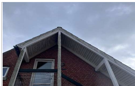
Reparation eller maling af vindskeder og stern.
