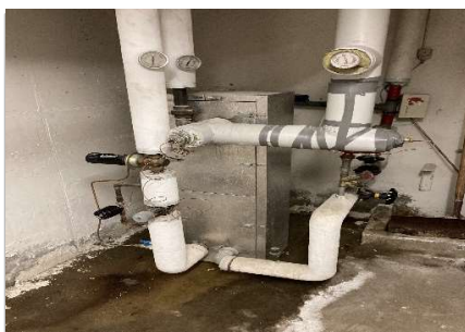
Udskiftning af varmeveksler.
