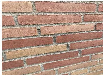
Omfugning af murværk.
