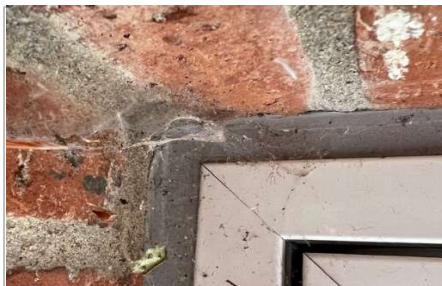
Udskiftning af gummifuger ved vinduer.
