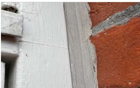
Udskiftning af gummifuger ved vinduer.
