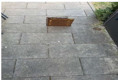
Udskiftning af brønddæksler på stier.
