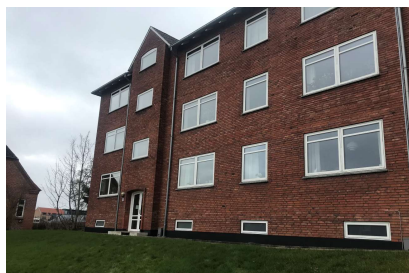
Omfugning af murværk
