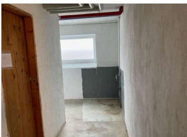
Maling af kældervægge
