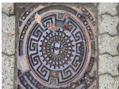
Udskiftning af pumpebrønd
