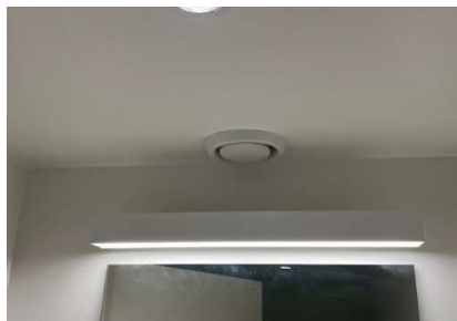
Rens af ventilationskanaler
